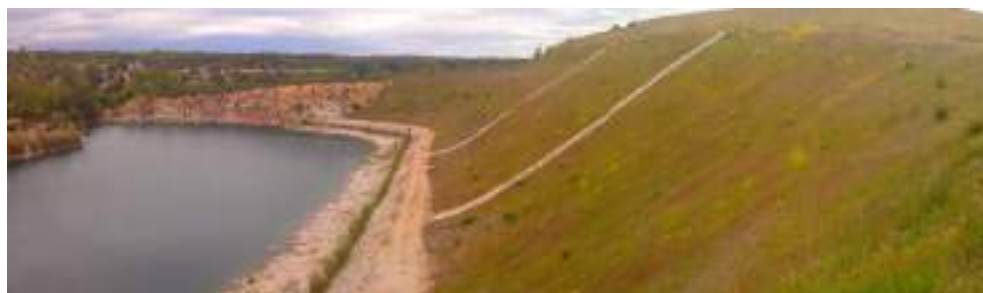
Figura 6. Estado de la cobertura de vegetación en el talud en mayo de 2013.
