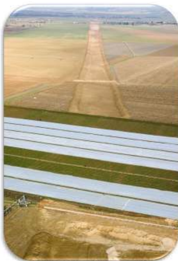
Figura 2. Coordinación de la ejecución de las obras y de la recolección de cultivos. En la parte superior pueden observarse los cordones laterales de tierra vegetal acopiada.
