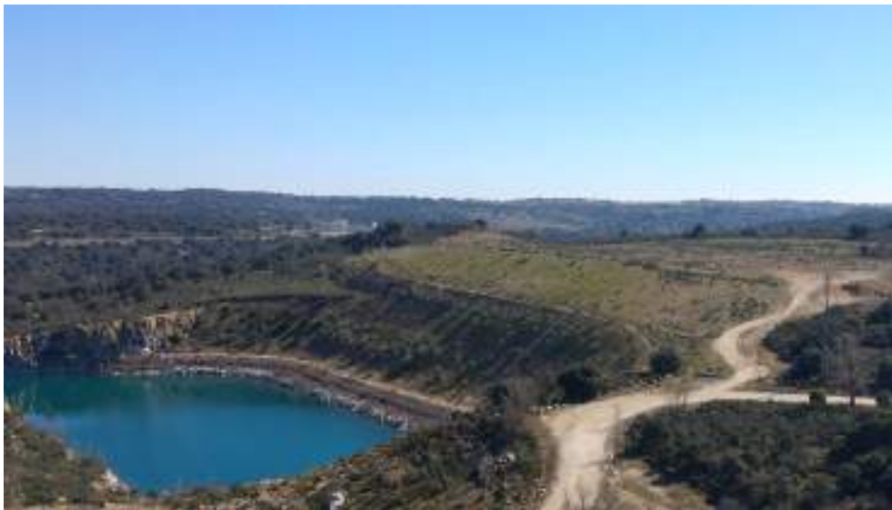
Figura 8. Estado de la zona restaurada febrero de 2017.
