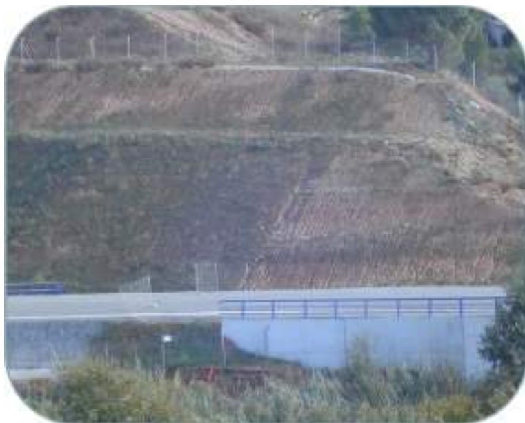
Figura 2. Talud de desmonte hidrosechado con y sin tierra vegetal.
