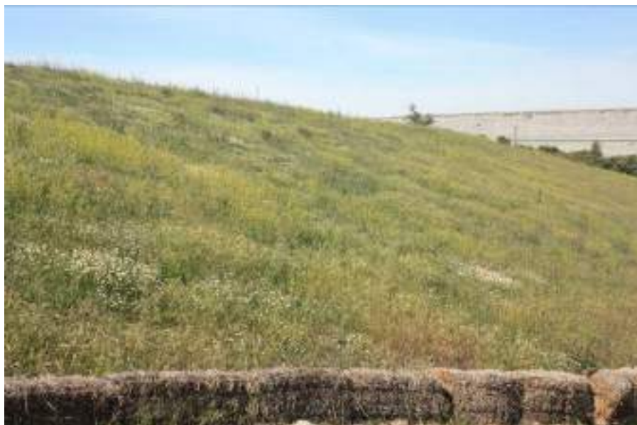
Figura 5. Estado de la cobertura de vegetación en el talud en mayo de 2012.
