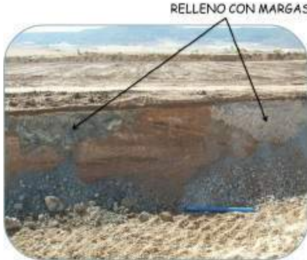
Figura 1. Relleno en zona de préstamo con material margoso.
