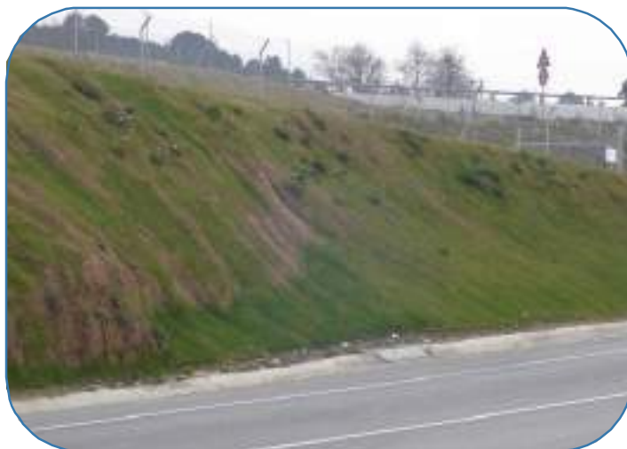
Figura 5. Red orgánica instalada en talud de desmonte.
